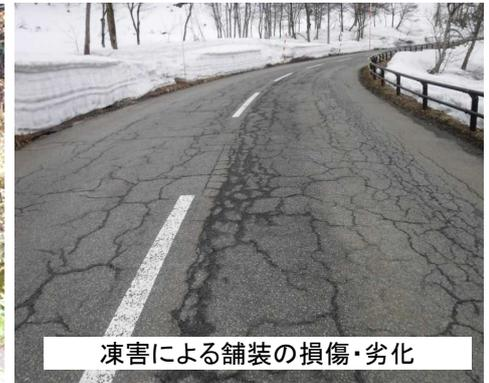
凍害による舗装の損傷・劣化
